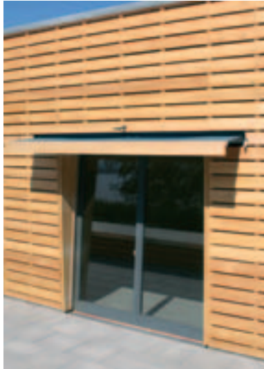
Die Verschattungselemente für den sommerlichen Wärmeschutz sind unauffällig in die Fassade integriert
