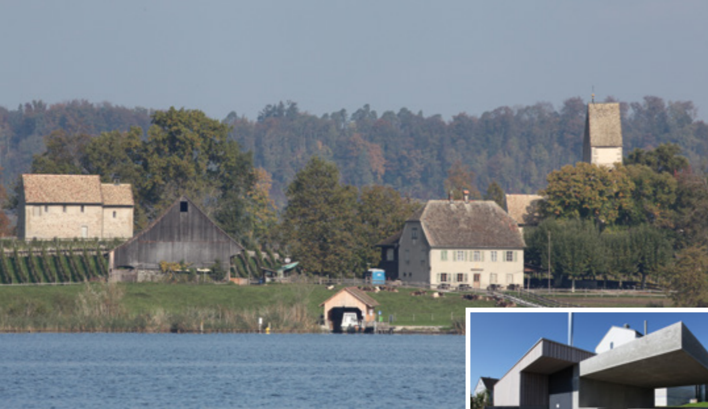
Above: Haus zu den zwei Raben 1681, restauration. Right: New central heating plant, Hombrechtikon.
