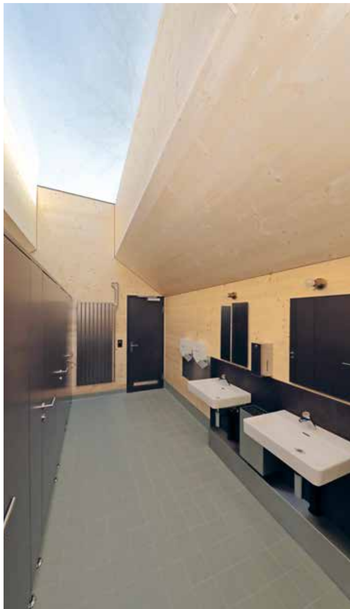
Der einzige Neubau des Projekts ist das frei stehende Toilettenhaus, das anstelle eines Schuppens erstellt wurde. Seine Form leitet es von den bestehenden Bauten auf der Insel ab.
