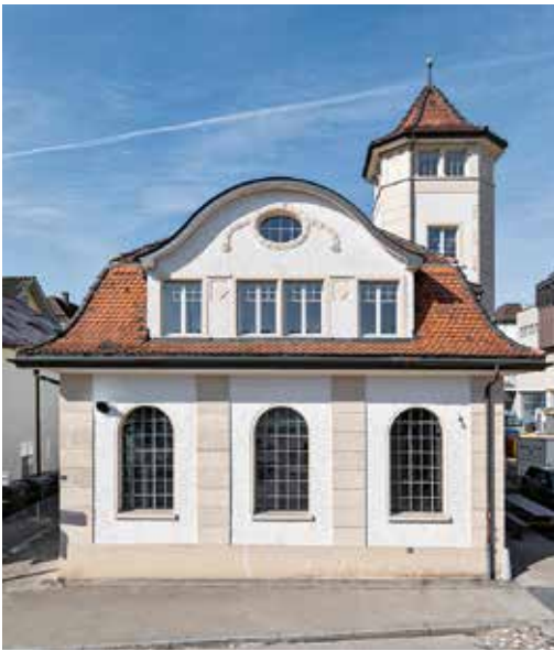
Zu den sorgfältig aufgeführten Fassaden gehören auch die originalen Eisenfenster im Erdgeschoss und die rekonstruierte Sprossenteilung im Obergeschoss.
