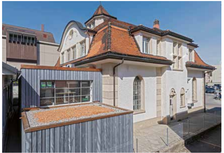
Zu den sorgfältig aufgeführten Fassaden gehören auch die originalen Eisenfenster im Erdgeschoss und die rekonstruierte Sprossenteilung im Obergeschoss.
