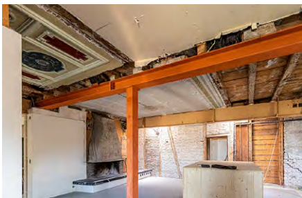
Der Blick ins Dachgeschoss während des Umbaus lässt die grosse Eingriffstiefe von 1967 erkennen.
